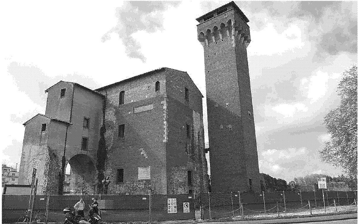
Il cantiere allestito al fortilizio della Cittadella e alla Torre Guelfa
