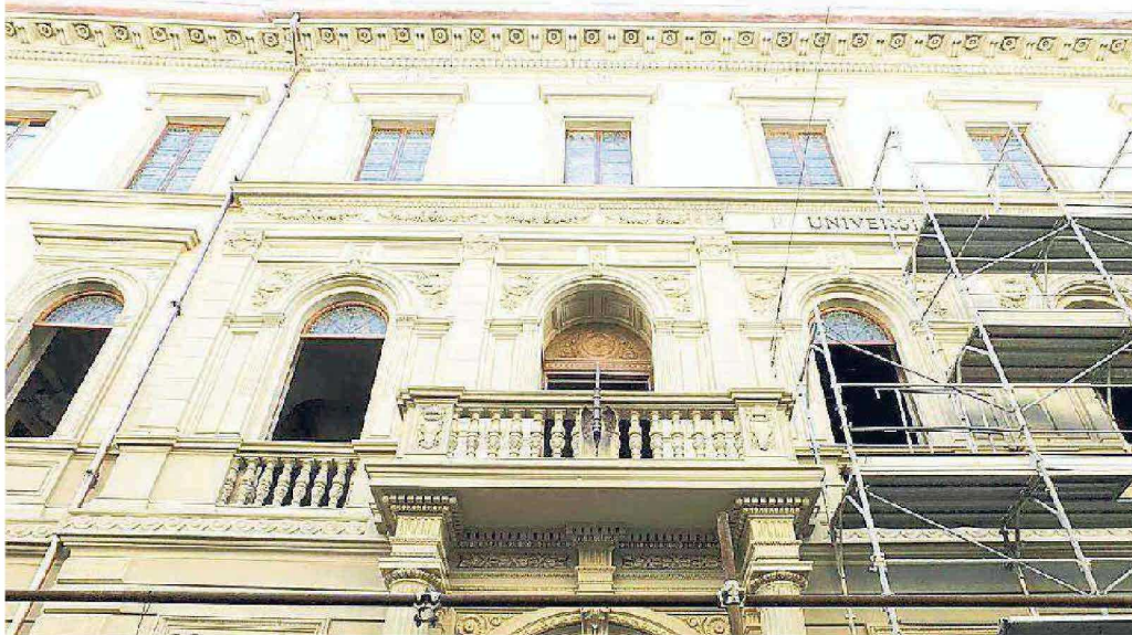
Il cantiere al palazzo della Sapienza
